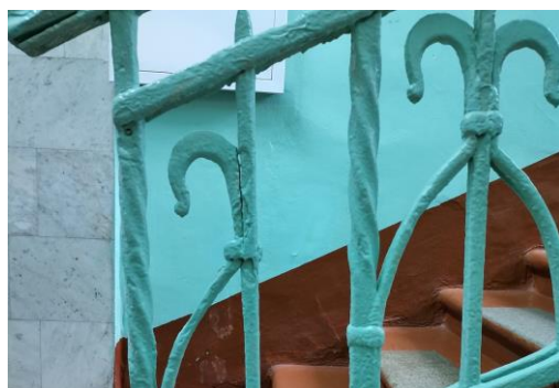
Ил. 1. Ограждение лестницы. Место утраченного декоративного элемента (снимок авторов)
